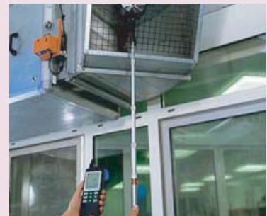
덕트 아울렛의 풍속 측정
